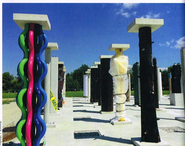
Die Verbindungsplatte ähnelt einem Kapitell und beherbergt ausgeklügelte Anschlussbewehrung für die biegesteife Verbindung. Sie wird nach der Montage des Kunstwerks einfach auf die Stütze aufgeschraubt. Danach kann das gemeinsame Dach fertiggestellt werden.
